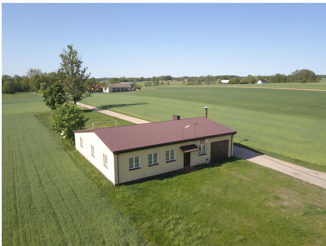
Budynek Ochotniczej Straży Pożarnej w Marianowie
