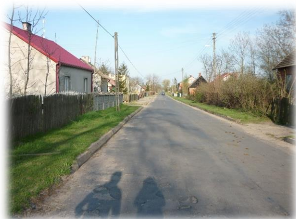
Rys.3 Zniszczony odcinek ulicy.
