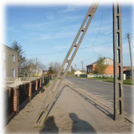
Rys 4 Odcinek ulicy bez chodnika
